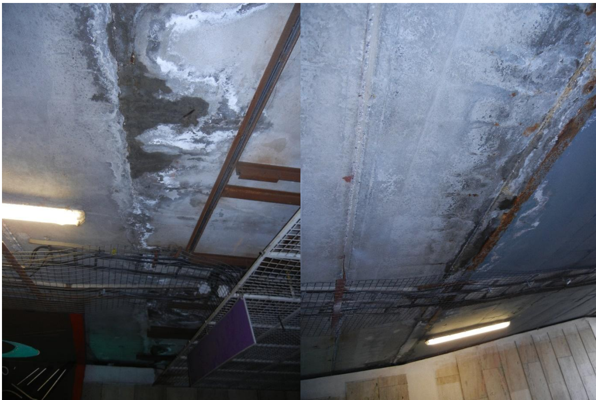
Detail spáry resp. přechodu nosníky rám x KA x rám – zatékání na podhledu
